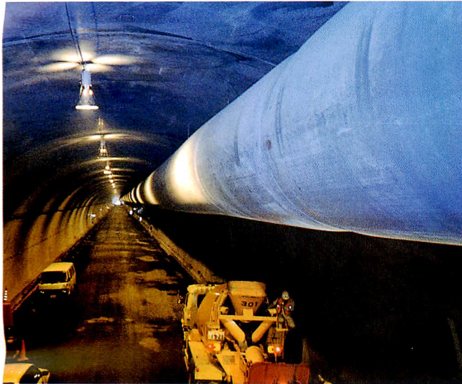
ナトム工法工事でのFST風管実用例
