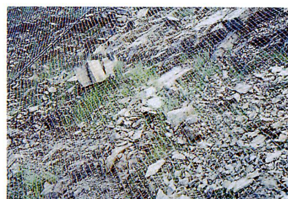
落石防止ネット ●ポリエチレン製 30mm、37.5mm目合 ●標準サイズ:5m×10m、10m×15m
